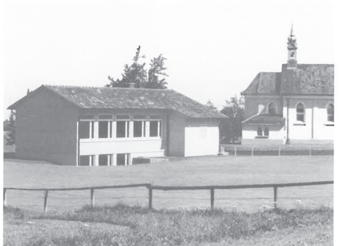
▲ Das «neue» Schulhaus Oberwald nach Baubeendigung
