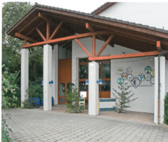
▲ Eingangspartie zum Mehrzweckgebäude
